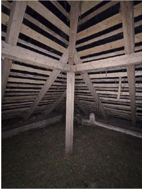
1 pav. Stogo konstrukcijos
