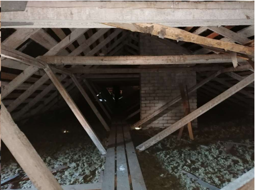
4 pav. Stogo konstrukcijos
