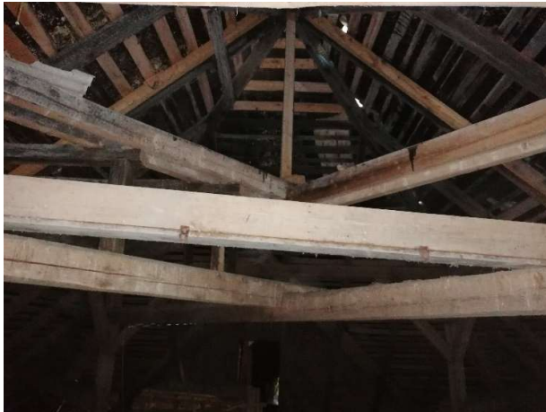
7 pav. Stogo konstrukcijos
