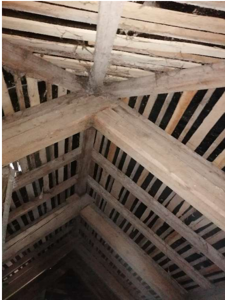
3 pav. Stogo konstrukcijos
