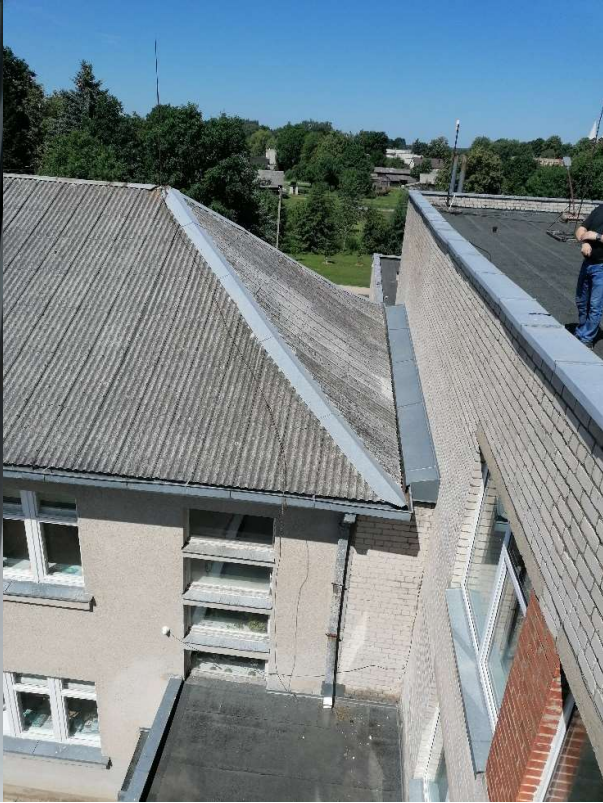
10 pav. Stogo danga iš išorės
