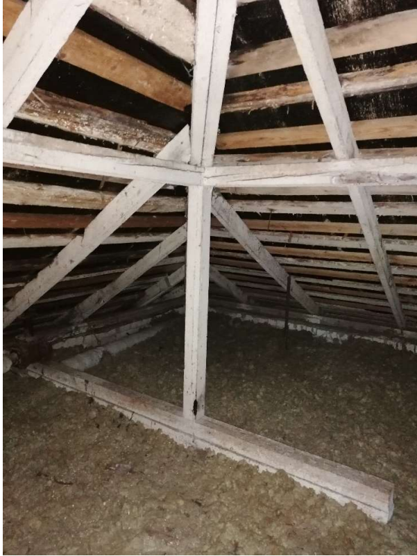
5 pav. Stogo konstrukcijos
