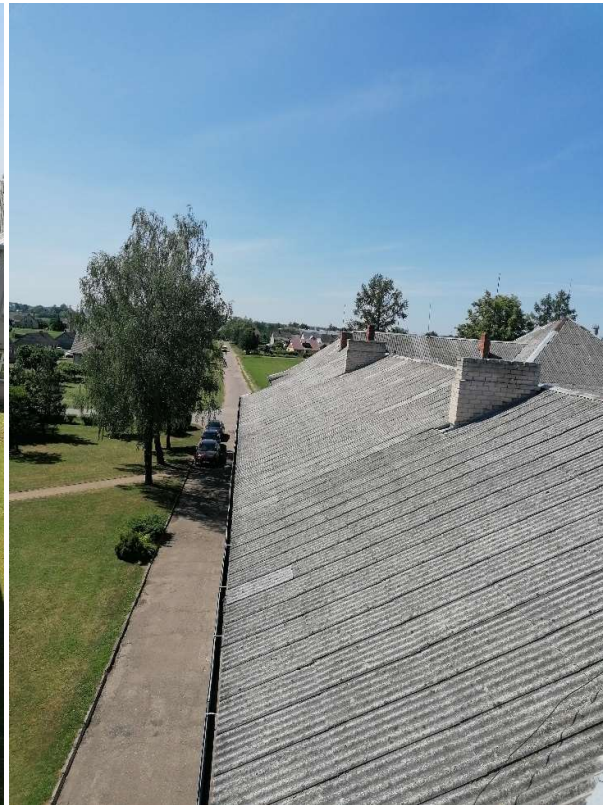
12 pav. Stogo danga iš išorės
