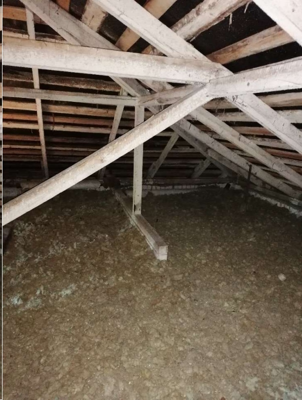
6 pav. Stogo konstrukcijos
