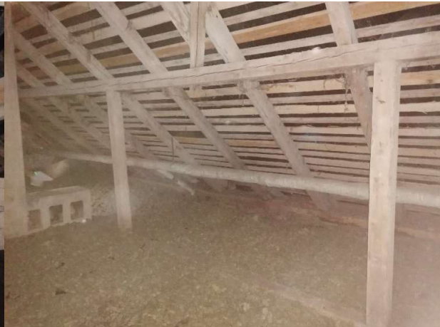
8 pav. Stogo konstrukcijos
