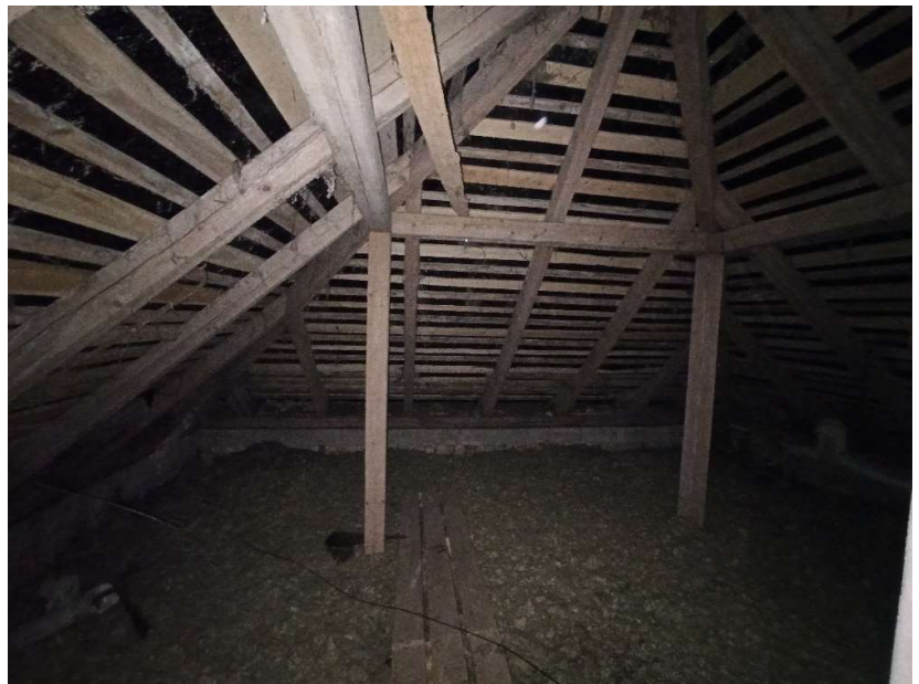
2 pav. Stogo konstrukcijos
