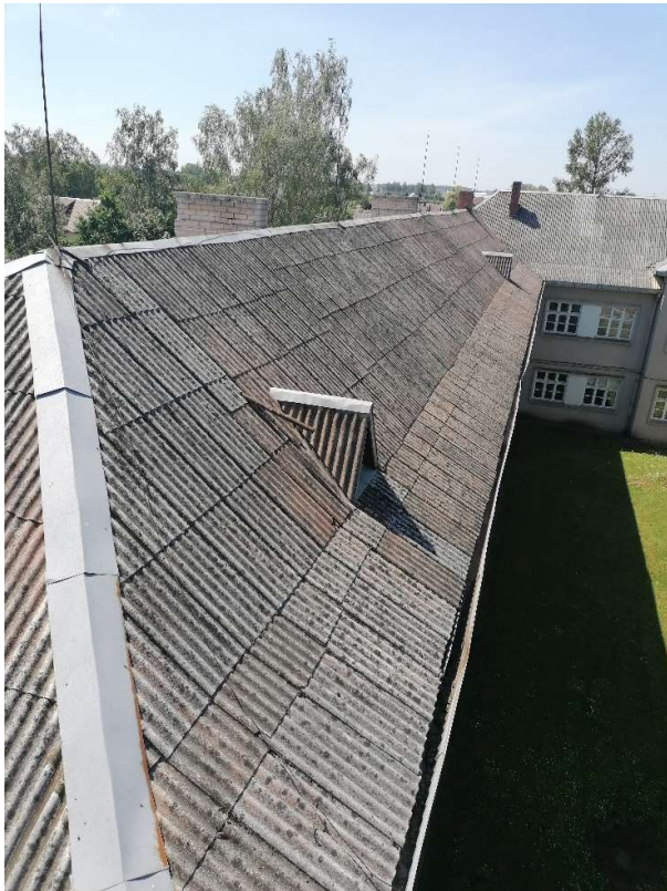
11 pav. Stogo danga iš išorės
